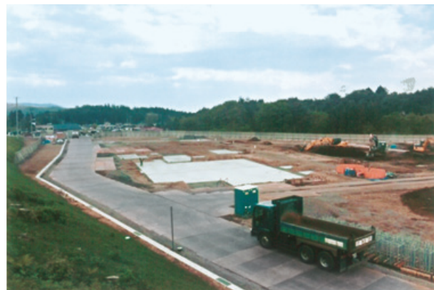
工事が進む岩手県野田村の木質バイオマス発電所（本年5月撮影）
