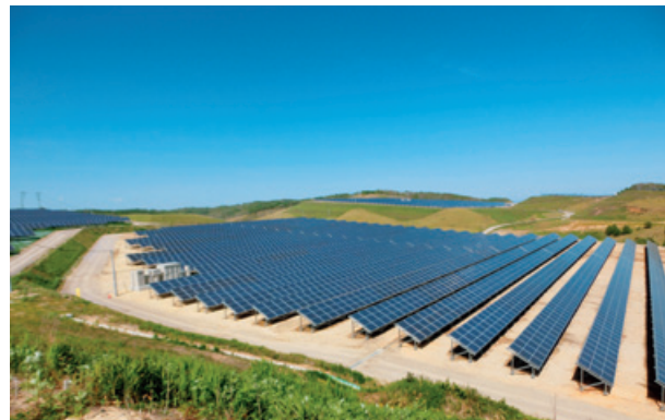
広大な丘陵地に建設された釧路の太陽光発電所
