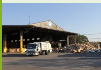
JP資源 小山事業所 JP Resources Co., Ltd. - Oyama Plant
